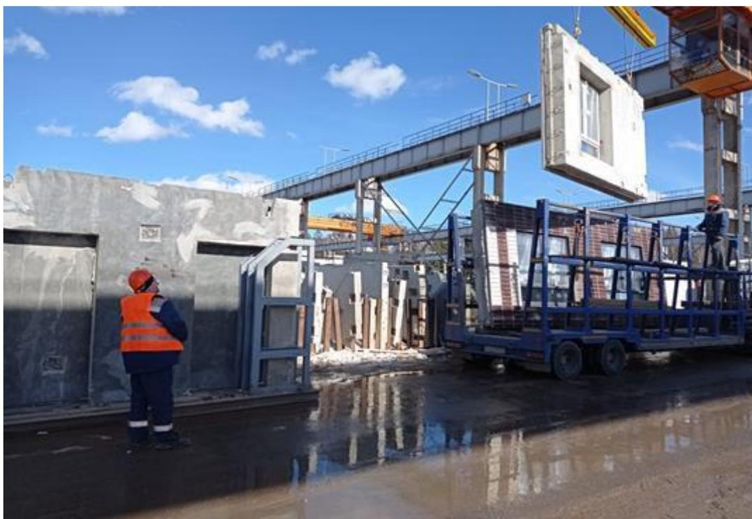
8. После проведения вышеуказанной проверки, водитель панелевоза, с соблюдением необходимых требований безопасности, уведомив стропальщиков о нахождении в полуприцепе панелевоза, может быть допущен к фиксации железобетонных панелей двумя и более транспортными раздвижными упорами (при укомплектованности панелевоза), в следующем порядке:
